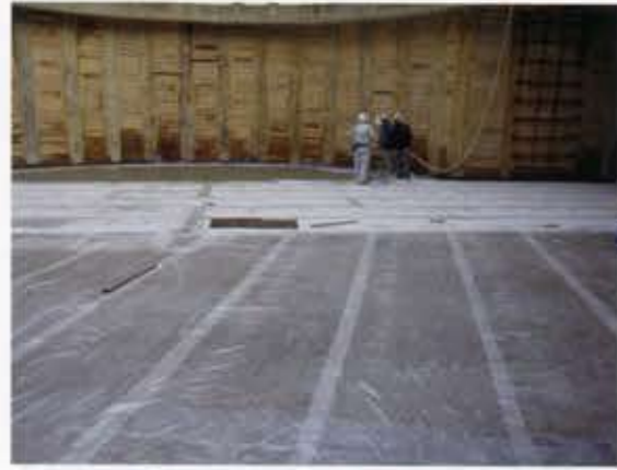
[ 捨てコン上 貼付状況 ]
