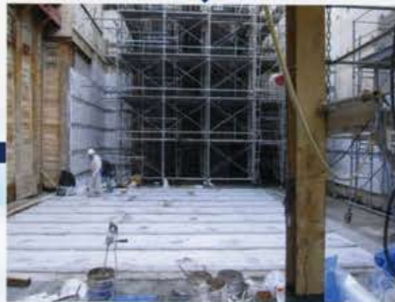
[ 地下外壁・耐圧盤下部 貼付状況 ]
