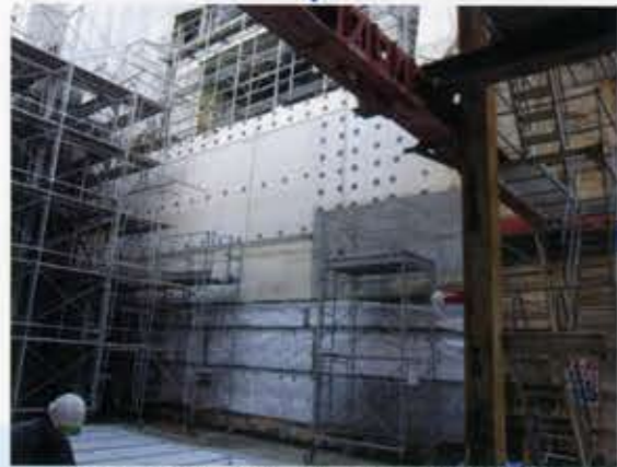
[ 地下外壁・耐圧盤下部 貼付状況 ]
