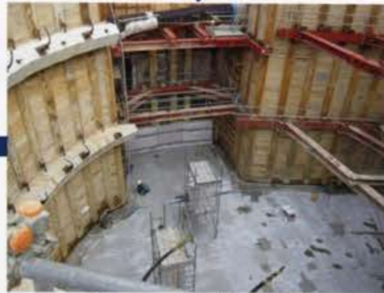
[ 捨てコン上 施工完了 ]
