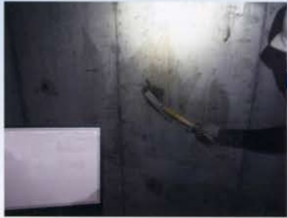
【プライマー塗布】
