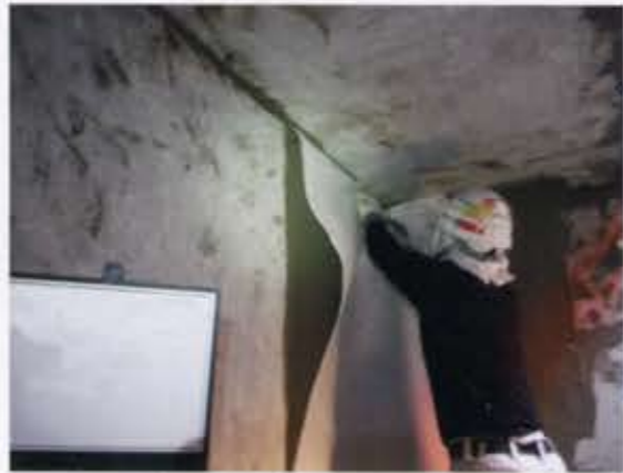
【アクアシート貼布状況】
