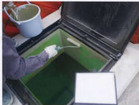
【エポキシ樹脂塗布状況】
