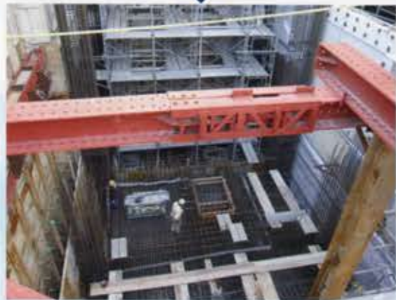
[ 地下外壁・耐圧盤下部 施工完了 ]
