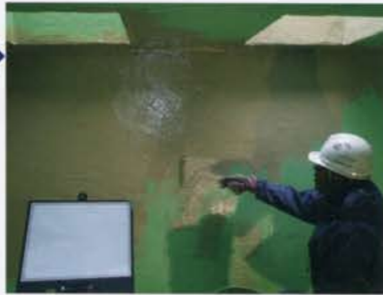
【エポキシ樹脂塗布状況】
