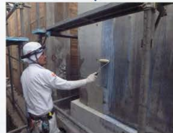
[ プライマー塗布 ]
