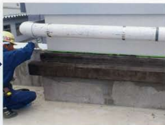
[ プライマー塗布 ]
