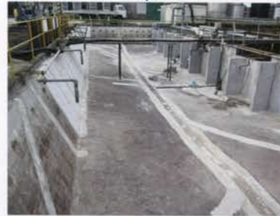
[ クラック発生部アクアシート増貼り ]
